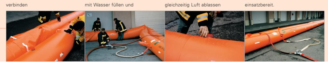
Gerade bei Unwetter ist der schnelle Aufbau eines Schutzdamms sehr entscheidend. Durch Aufsetzen eines weiteren Schlauches kann die Stauhöhe im Notfall schnell und einfach erhöht werden.
